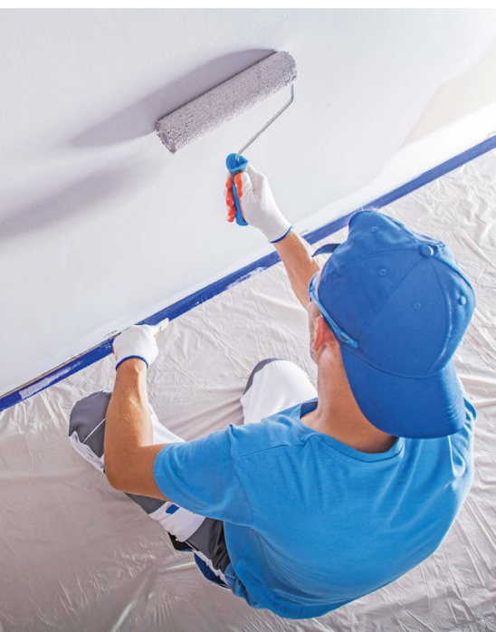
Im Ausbaugewerbe rechnet man – im Gegensatz zum Bauhauptgewerbe – mit einer weiter leicht steigenden Nachfrage.
